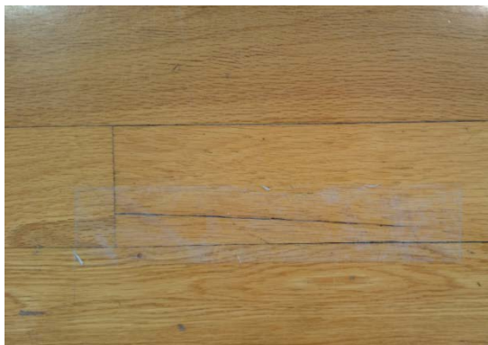
写真 3 床板の割れを テープで補修
