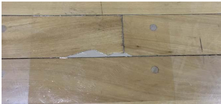
写真 5 パテによる補修例
