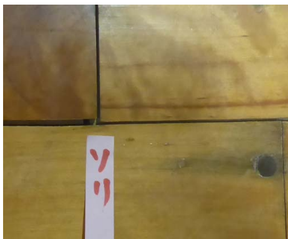
写真 7 目隙(長さ 590mm、幅 3.9mm)、 段差(0.5mm)
